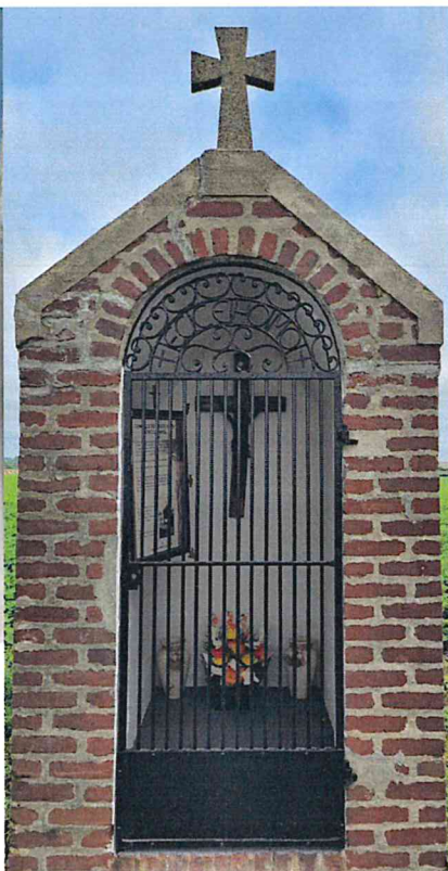
Avant et après les travaux
